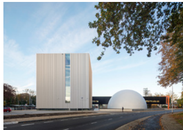
2015 Museumplein Limburg Uitbreiding bestaand museumcomplex tot een nieuw museumkwartier met twee nieuwe instellingen
