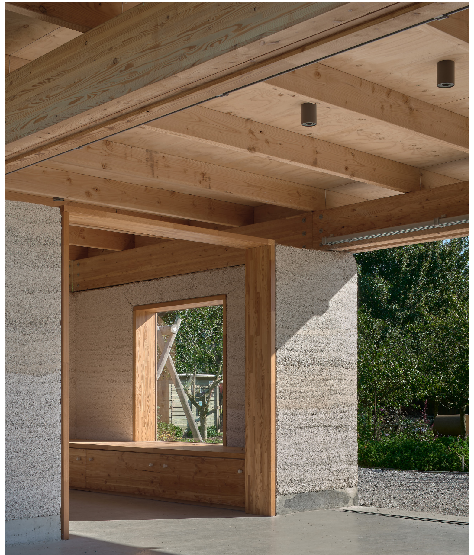
Het uitkragende dak en de betonnen plint beschermen de onbehandelde hennepkalk gevels. Zorgvuldig geplaatste larikshouten elementen kaderen het landschap in en versterken de relatie tussen binnen en buiten.
