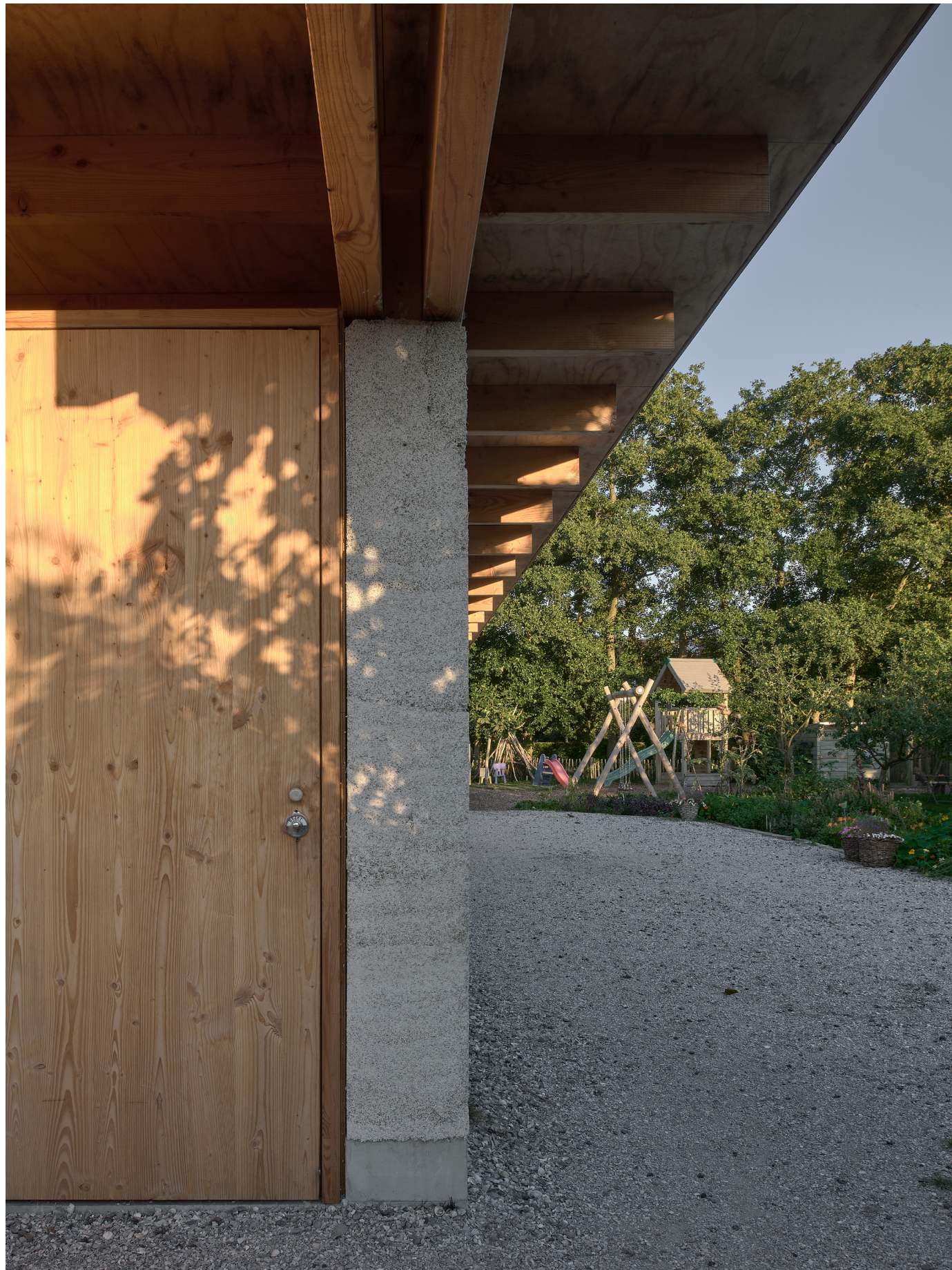
Het uitkragende dak en de betonnen plint beschermen de onbehandelde hennepkalk gevels. Zorgvuldig geplaatste larikshouten elementen kaderen het landschap in en versterken de relatie tussen binnen en buiten.
